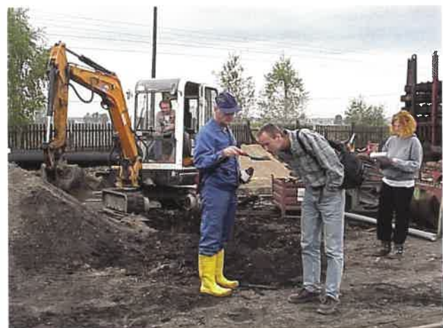
Abb. 4: organoleptische Ansprache von Bodenmaterial
