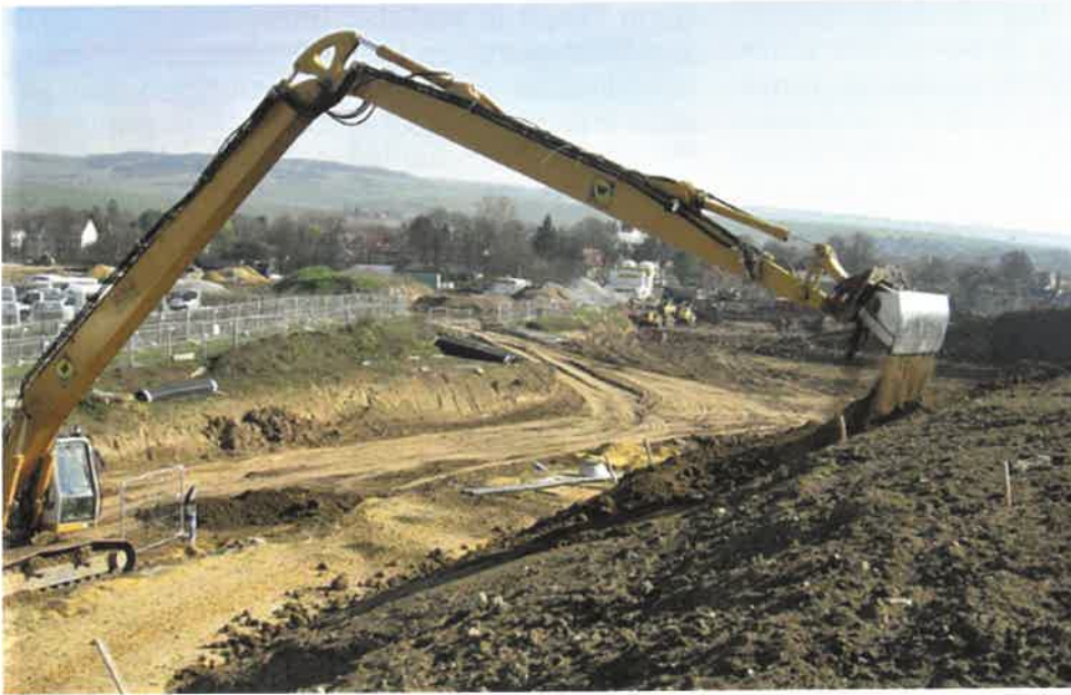
Abb. 3: Verfüllung einer Abgrabung, Quelle: Hessisches Ministerium für Umwelt, Klimaschutz, Landwirtschaft und Verbraucherschutz
